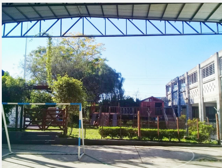
Cerramiento lado este
